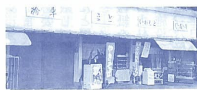
解体前の食堂
