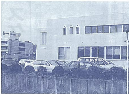
新時代を迎える杵藤広域圏庁舎向う側建物は市役所
