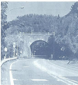
35号線踊瀬のS字カーブ付近
