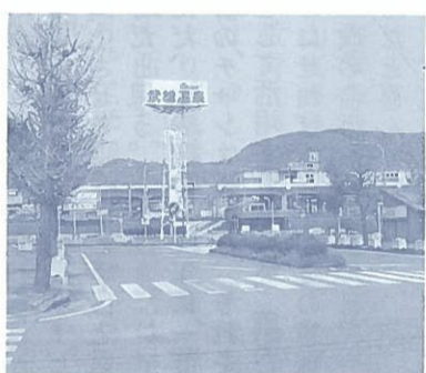
④ 駅南ロータリー歩道整備
