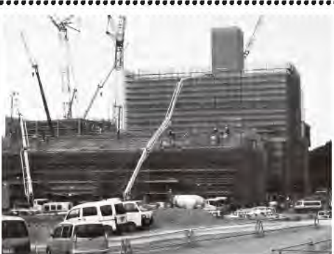
建設中の西部広域ゴミ処理場
